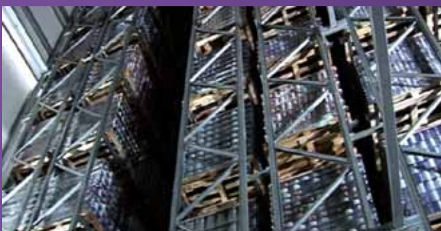
Автоматический накопитель банок (7.000 поддонов)
